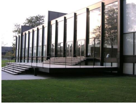
صورة رقم (8) توضح تصميم المباني من الخارج واستخدام اللاندسكيب
